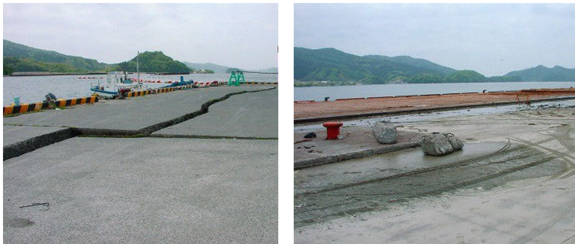
図 1.1.3 大船渡港でみられた岸壁の亀裂（左）および液状化現象の痕跡(右)
