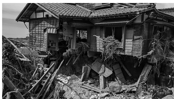
図2 小岩内地区の土石流被害
