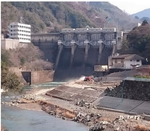
Figure 3. 鹿野川ダム(左 ダム事務所)
